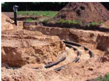
Plaatsing van de 3 flexibele AWW-buizen
